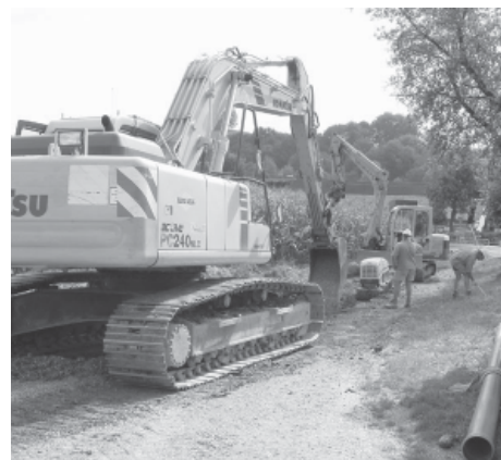
Kanalbau nach Vornwald.
