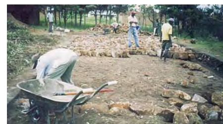
Die Grundsteine für den Bau des Heimes für Berufsschüler in Kehancha werden gelegt.
