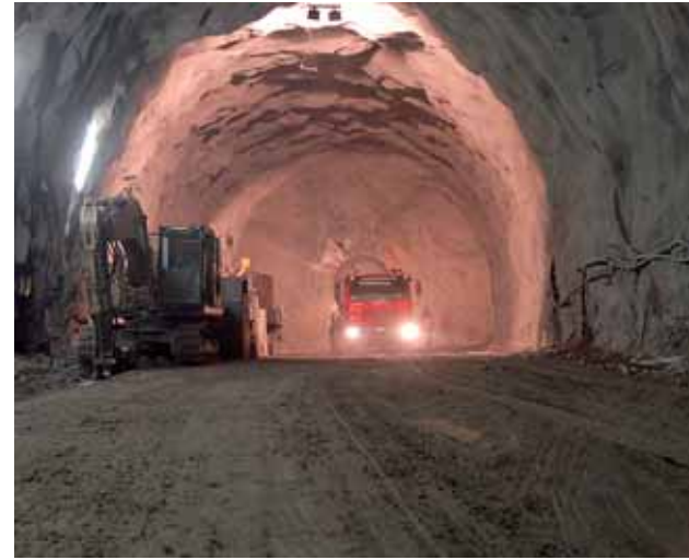
Der 541 Meter lange Tunnel für die Umfahrung Forst-Töll vor dem Durchstich Foto: Il tunnel di Tel prima della caduta dell'ultimo diaframma
