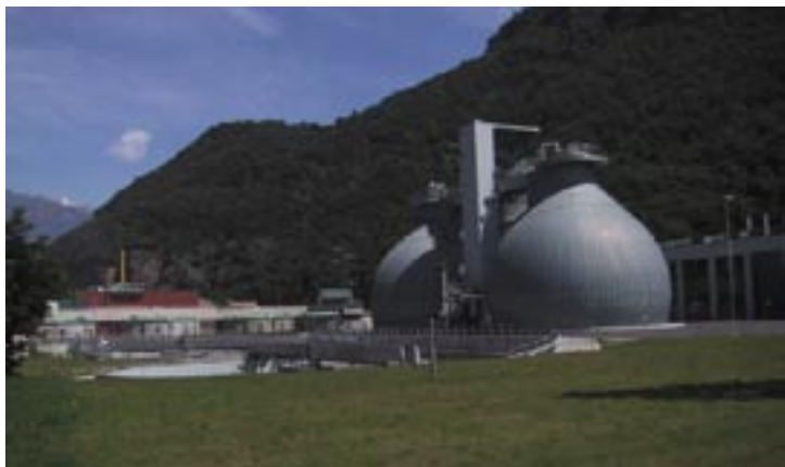
Auch die Abwässer der Gemeinde Schenna werden in die übergemeindliche Kläranlage in Sinich eingeleitet
