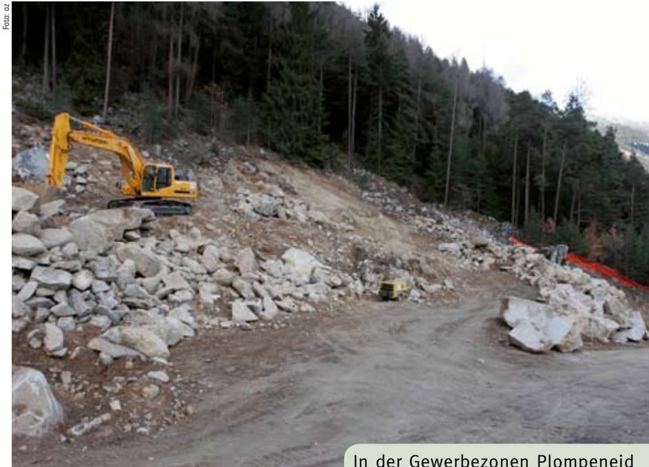
In der Gewerbezone Plompeneid wurde der Bau eines Steinschlag-schutzgrabens vorbereitet
