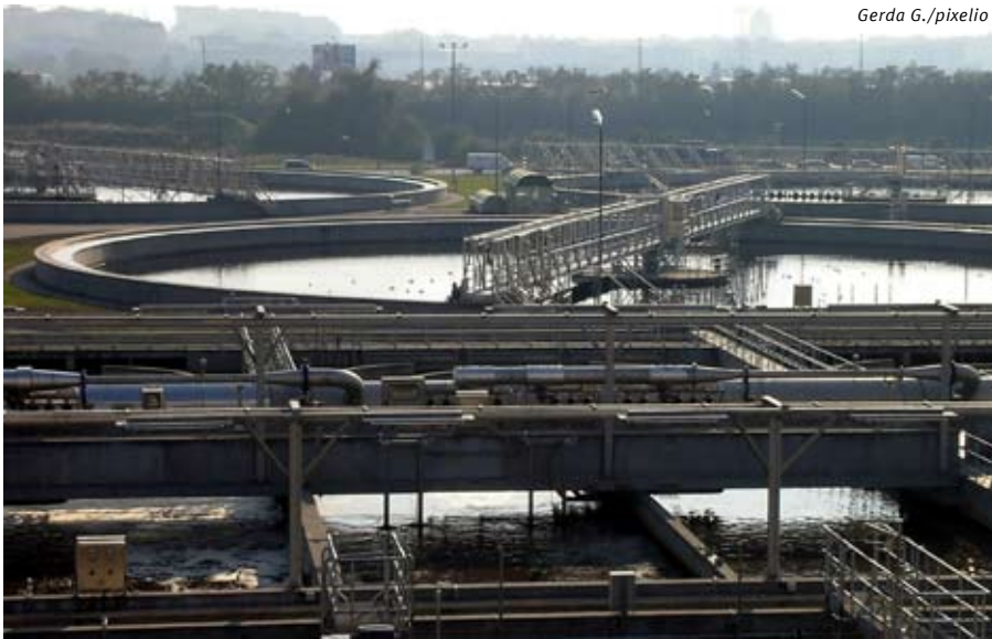
Abwasser-Kläranlage; Belebungsbecken zur biologischen Reinigung
