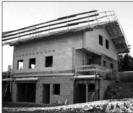
Der Rohbau auf der Liegalm
