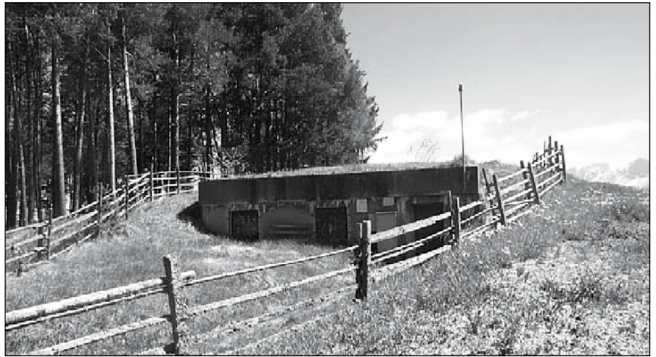
Der alte Wasserspeicher
