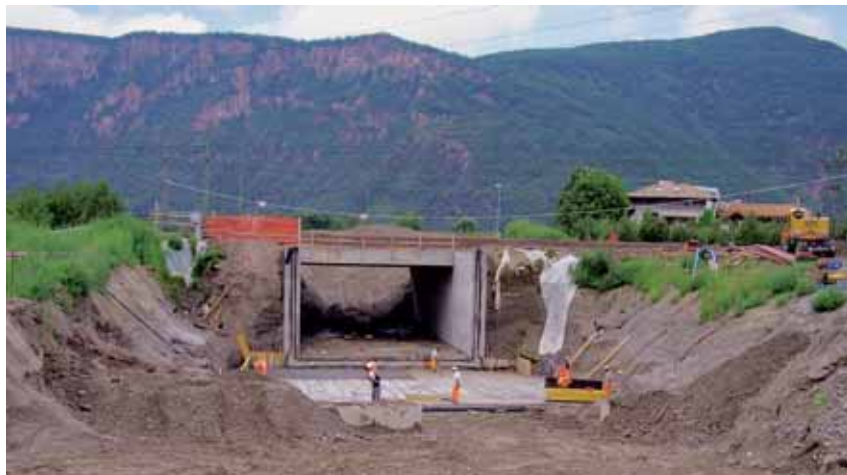
L'apertura del nuovo sottopasso alla Dogana inciderà anche sulla viabilità interna del paese.
