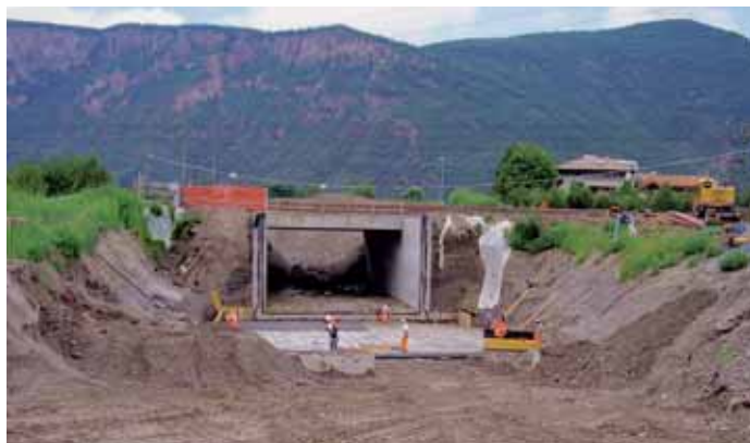
Die Eröffnung der neuen Unterführung bei der Branzoller Lende wird auch auf den Verkehr innerhalb des Dorfes Auswirkungen haben.
